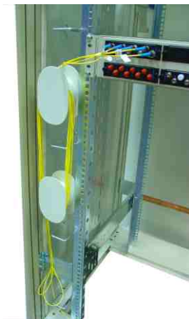
DOVODI104 Vodilo kablov optika
